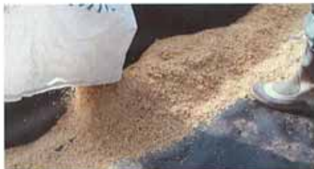
4. 暗渠周囲への籾殻投入
