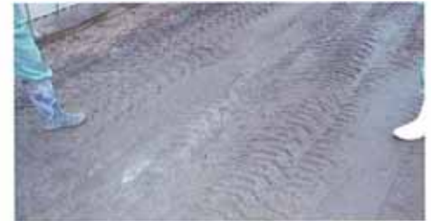
12. 完成した基盤表面
