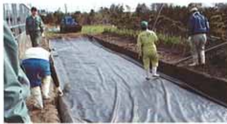
2. 防水シートの設置
