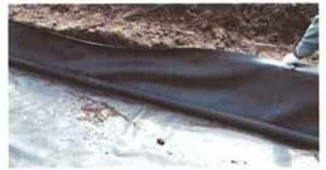
3. 暗渠パイプの設置
