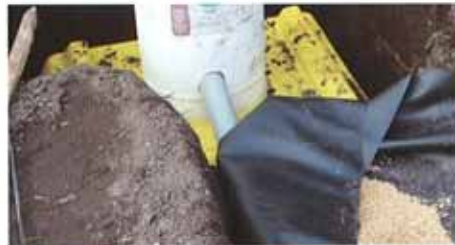
5. 汚水溜へのパイプ接続
