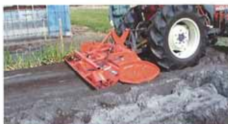
7. 土壤硬化剤の攪拌と混合
