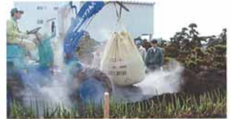
6. 搬出土へ土壤硬化剤の散布
