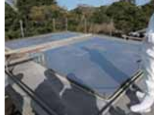
原尿槽の密閉の様子
