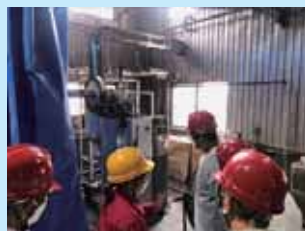
今回導入したボイラー視察： 田崎工場長
