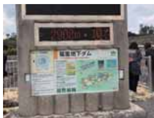
世界初！地下水を貯水する 『地下ダム』を見学
